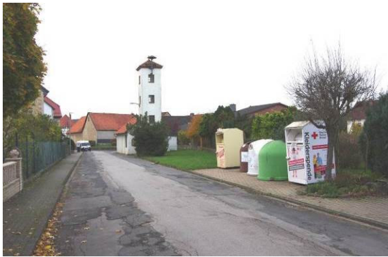
In Thüste weisen nahezu sämtliche innerörtlichen Straßenzüge Erneuerungsbedarf auf. Im Zuge von Am Mühlengraben ist dabei der Schwerlastverkehr sowie der Stellplatzbedarf zu bedenken.
