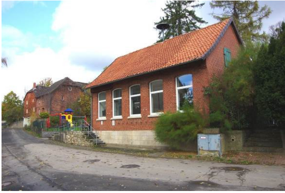
Das bis 1970 genutzte Schulgebäude dient seither als Dorfgemeinschaftshaus, an das ein Freisitz und der örtliche Spielplatz angeschlossen sind.
