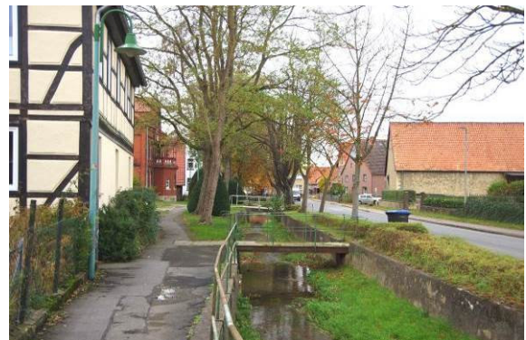
Im Verlauf durch den Ortskern von Thüste wird die Landesstraße durch die Thüster Beeke begleitet. Die bauliche Einfassung des Gewässers sowie die Nebenanlagen sind teilweise erheblich beschädigt.
