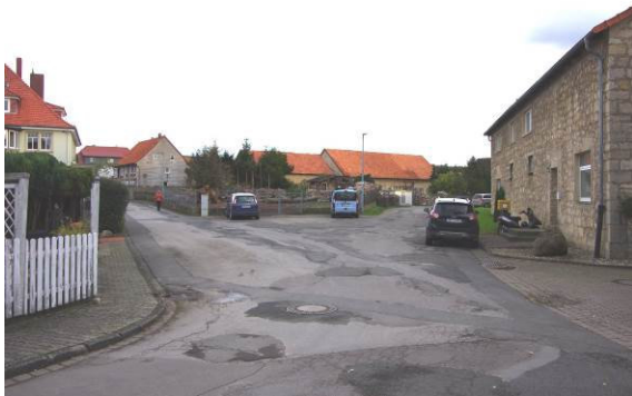
Die kommunalen Straßenzüge (hier Am Mühlengraben und Multhöpen ) sind durch schadhafte Oberflächen und großflächige Versiegelung gekennzeichnet.
