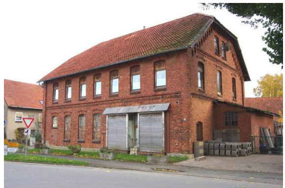
Die durch die traditionellen Gebäude geprägten Ortsbilder werden durch einige leerstehende oder abgängige Objekte erheblich beeinträchtigt.
