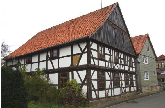
Der Ortskern ist durch markante Altgebäude geprägt, die teils bauzeitlich erhalten, aber vielfach durch bauliche Veränderungen gekennzeichnet sind.
