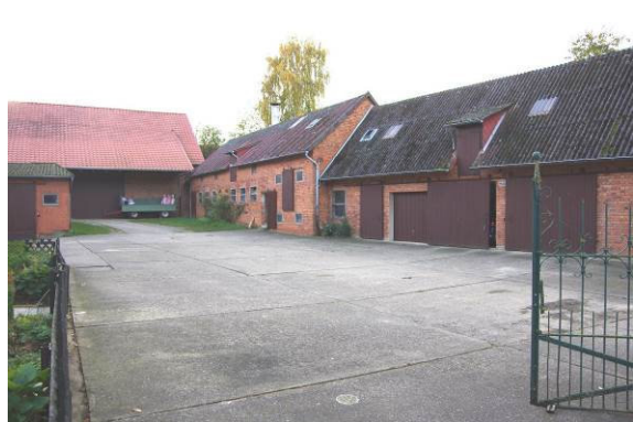
Auf den (ehemaligen) Hofstellen bestehen zahlreiche nicht mehr rentierlich zu nutzenden Wirtschaftsgebäude.
