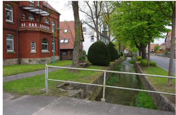
Der Bachlauf der Thüster Beeke begleitet im Ortsbereich Thüste weithin die Lange Straße .
