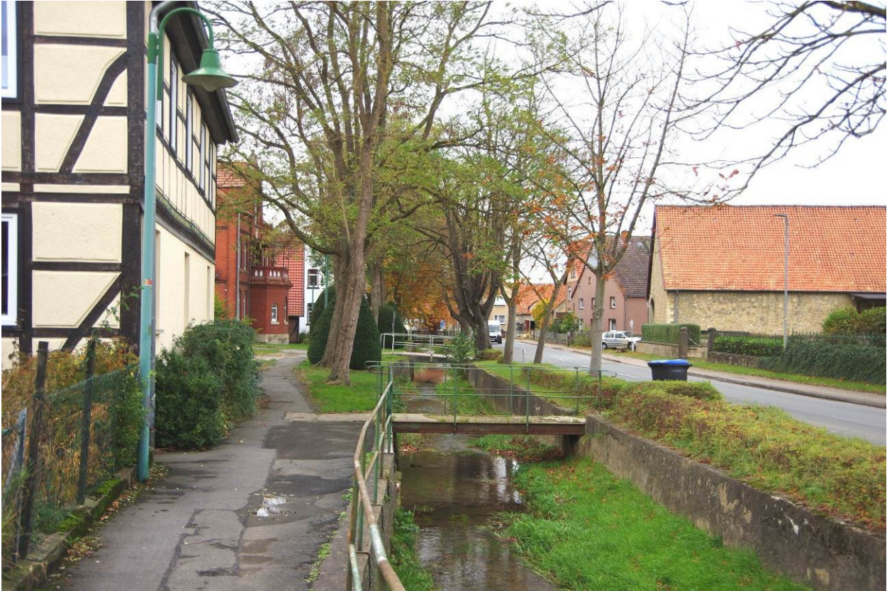
Im Verlauf der Lange Straße ist die gemauerte Einfassung des Bachlaufes insbesondere auf der südlichen Seite schadhaft. Das betrifft auch die Nebenanlagen (Gehwege und Grünstreifen mit Bepflanzung) sowie die Brücken zu den privaten Grundstücken.
