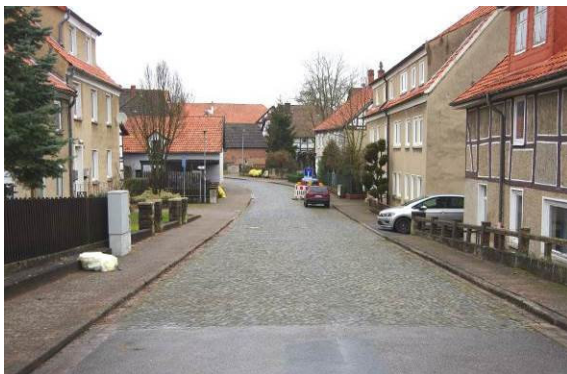
Die Bachstraße in Wallensen weist in ihrem nördlichen Abschnitt ein Basalt-Kleinpflaster auf, das bei der Erneuerung wiederverwendet werden sollte.
