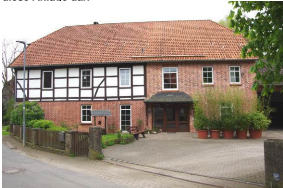
Beispielhaft ist hier die einst als Wirtschaftsbereich genutzte Gebäudehälfte um- und ausgebaut worden – der ursprüngliche Gebäudecharakter ist weiterhin ablesbar.
