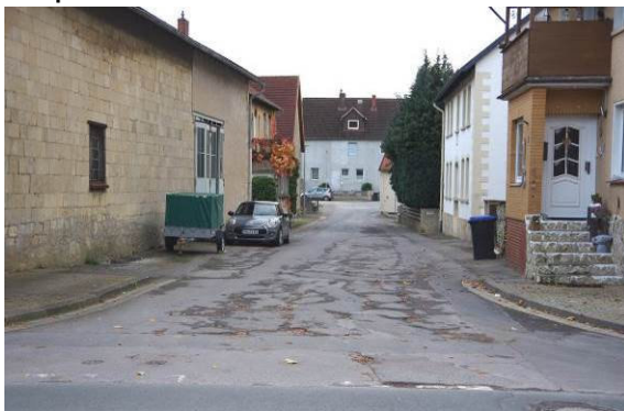
Schadstellen und Verformungen kennzeichnen auch die Straße Neuer Weg ; dazu besteht eine vollflächige Versiegelung.
