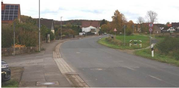
Die westliche Ortseinfahrt der Lange Straße (L 462) weist nur eine einzeilige Bebauung auf; hier wird die zulässige Fahrgeschwindigkeit oftmals überschritten.
