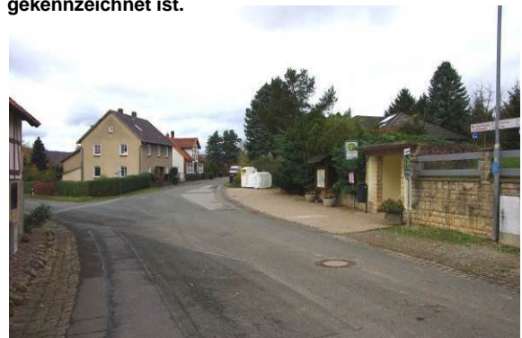
In Levedagsen endet die K 11 im Bereich der Einmündung der Sackstraße in die Alte Dorfstraße . Die Wendeschleife für den Bus muss bei der Neuanlage der Haltestelle berücksichtigt werden.
