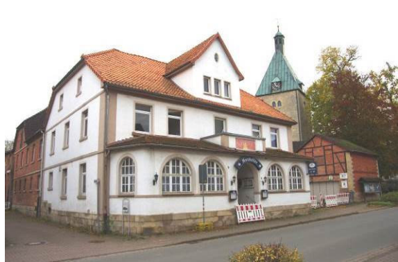
Als Lokal und Veranstaltungsort, aber auch als Baukörper prägte der Ratskeller die Ortsmitte von Wallensen. Nach dem baulich bedingten Abriss stellt sich die Frage der Folgenutzung.
