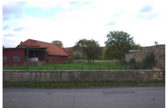
In den Ortslagen bestehen zahlreiche unbebaute Freiflächen, die zusammen mit den Flächen von abgängigen Altgebäuden Potential für eine Nachverdichtung bzw. Folgenutzung haben.
