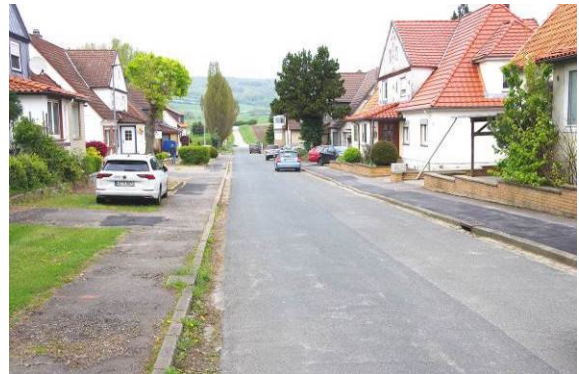
Weithin abgängig ist die Straße Bergmannssiedlung im gleichnamigen Siedlungsteil. Der breite Straßenraum bietet Gliederungsmöglichkeiten für eine Begrünung und für den Aufenthalt.
