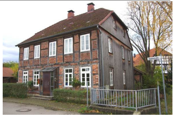
Aufgrund seines überlieferten Baubildes, aber auch aufgrund seiner Lage erweist sich dieser Fachwerkbau als ortsbildprägend.
