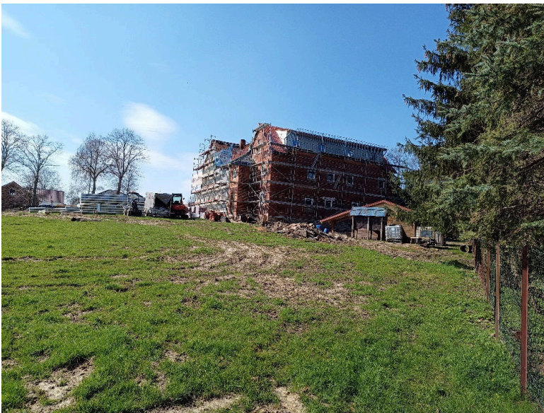
Abb. 7: Grünlandfläche, Baustelle im Norden
