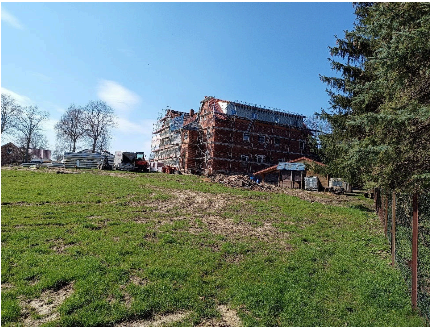
Abb. 9: Grünlandfläche, Baustelle im Norden
